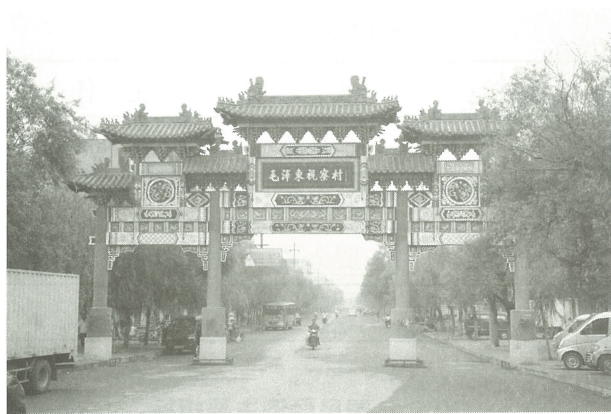
八七村“毛泽东视察村”牌楼
