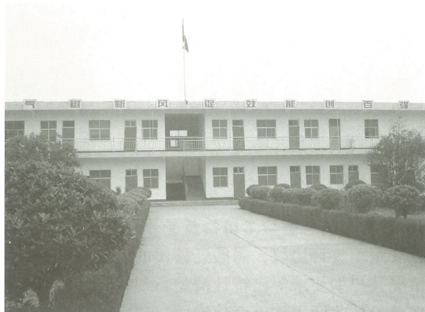
坡胡镇政府办公楼
