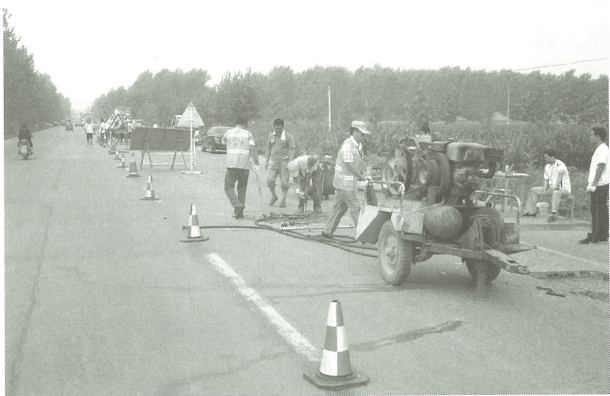
路面挖补坑槽施工场面
