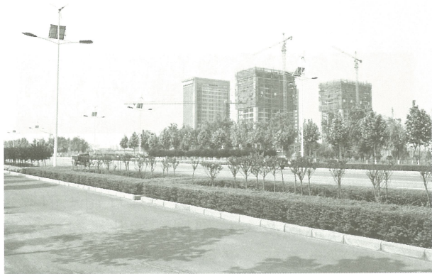
集聚区在建工程
