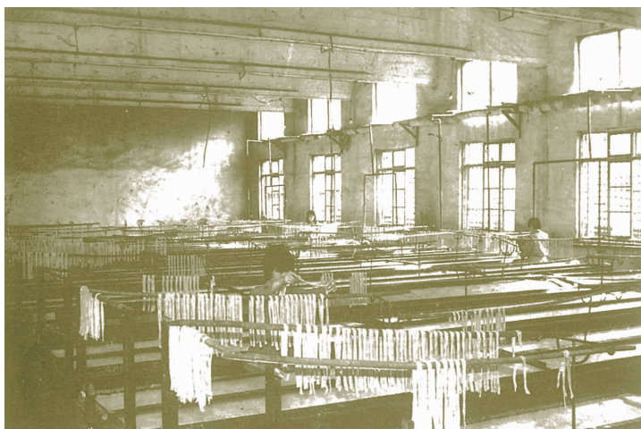
腐竹生产车间
