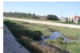
清渠河英刘闸上游城区段河道
