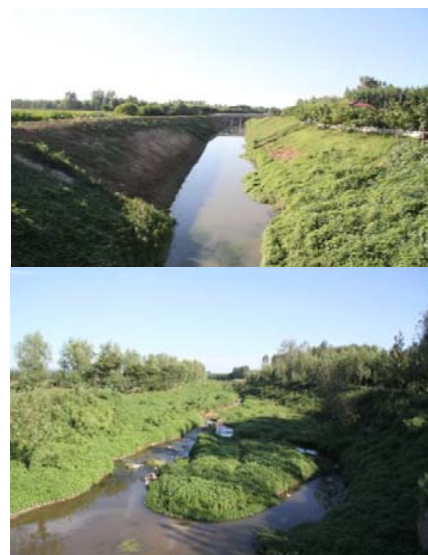
清溪河河道下游景观现状
