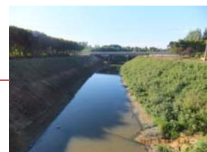
清渠河产业聚集区段河道
