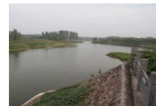
清漯河上游增福水库
