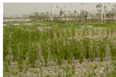
潜流湿地碎石床及植物
