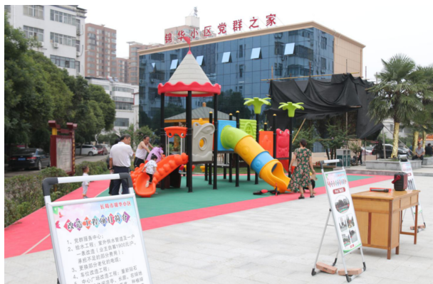
锦华小区改造提升过的现貌
