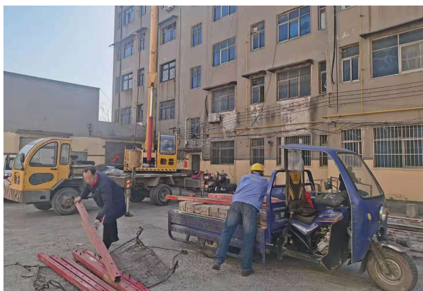
拆除私搭乱建工程
