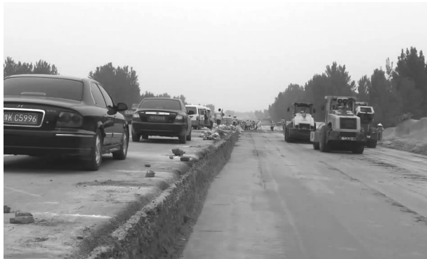
省道 225 机场快速通道施工现场
