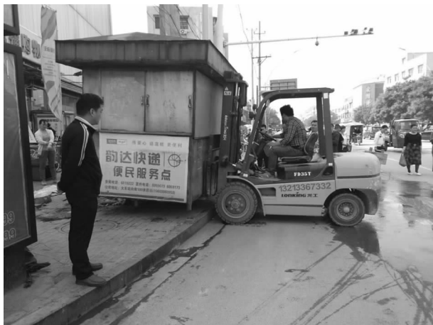
建设办拆除邮政报刊亭
