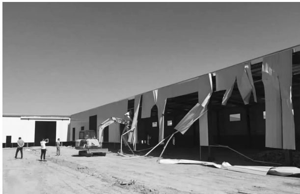
卫片治理拆除现场
