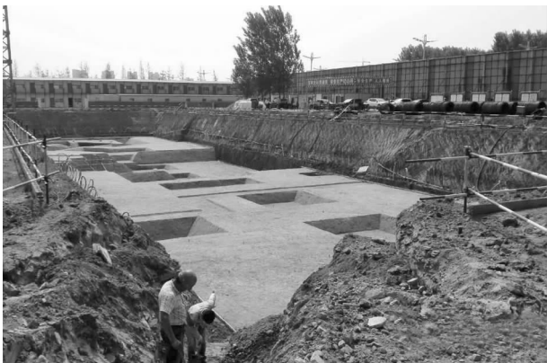
863 孵化园施工现场
