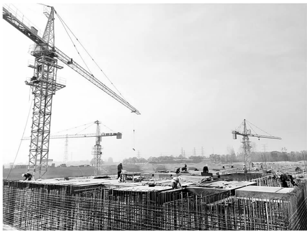
郑万高铁北站广场正在抓紧施工建设
